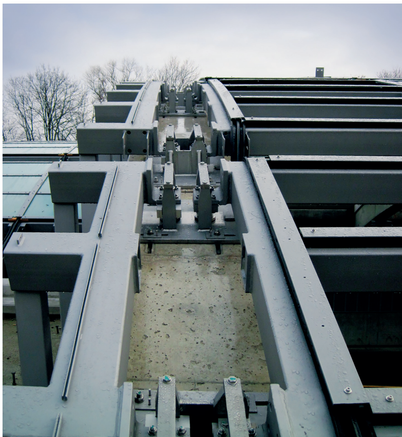
W szklanej konstrukcji dachu ekranu akustycznego autostrady w Kolonii-Lövenich zastosowano do mocowania agregatów wentylacyjnych szyny Halfena z wysokoodpornej na korozję stali nierdzewnej. (Zdjęcie: © Leviat)
